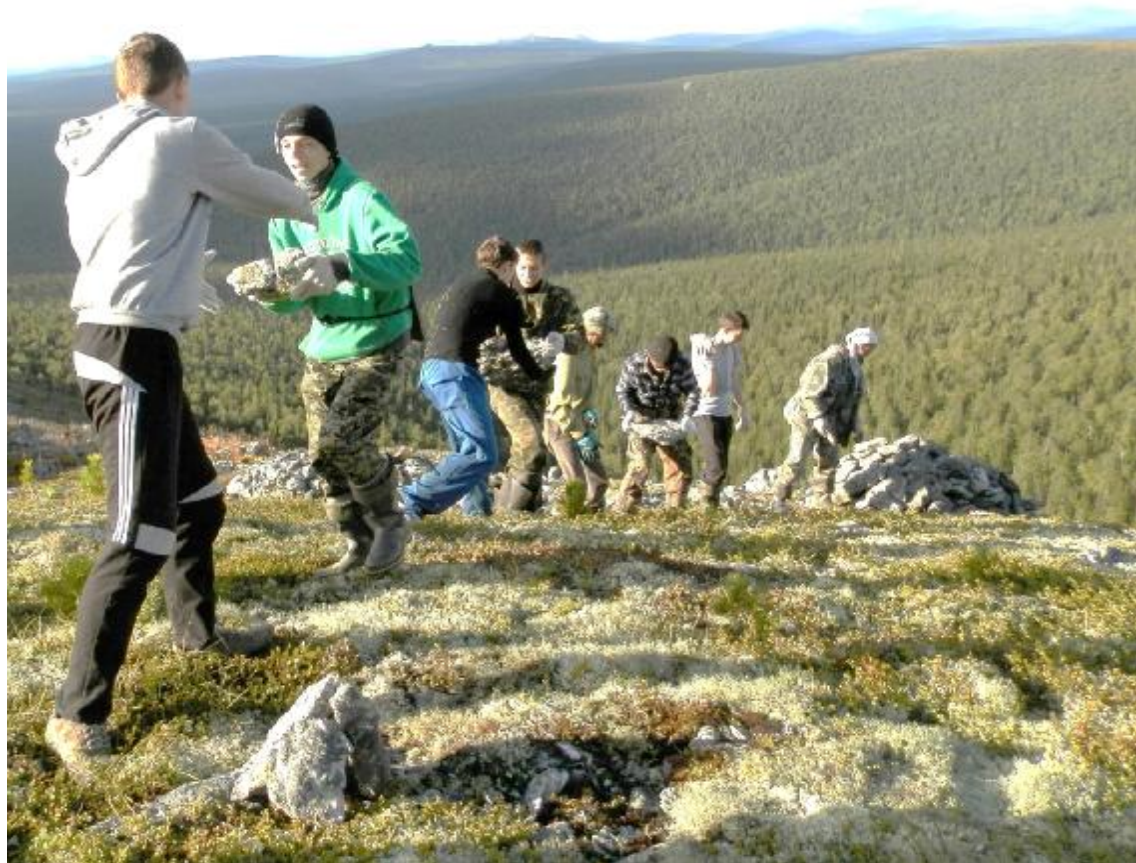
Обустройство туристических троп плато Мань-Пупу-Нёр. Волонтерская помощь работникам заповедника
