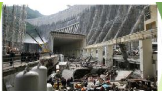
Катастрофа на Санжо-Шуоньской ГЭС (17 августа 2009 года)
